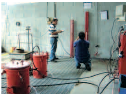
Equipamento para teste hidrostático. Camisas d'água
