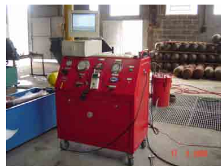
Equipamento para teste hidráulico. Bomba e painel de monitoramento
